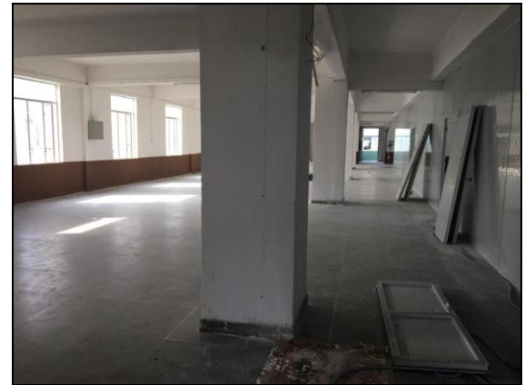
项目车间现状
