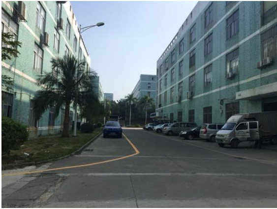
项目东面工业厂房
