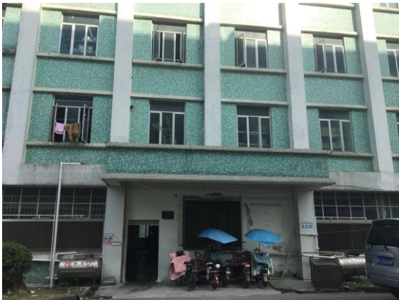
项目北面工业厂房
