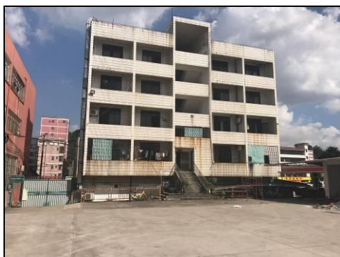
项目东面工人宿舍
