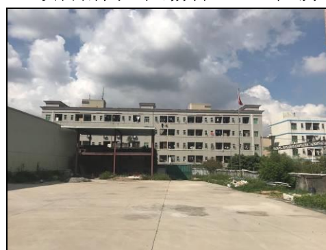
项目北面工人宿舍
