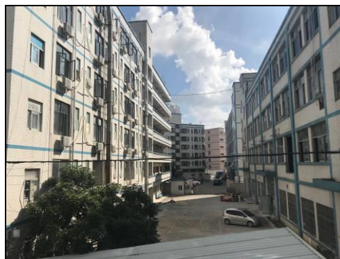
项目南面工人宿舍、工业厂房
